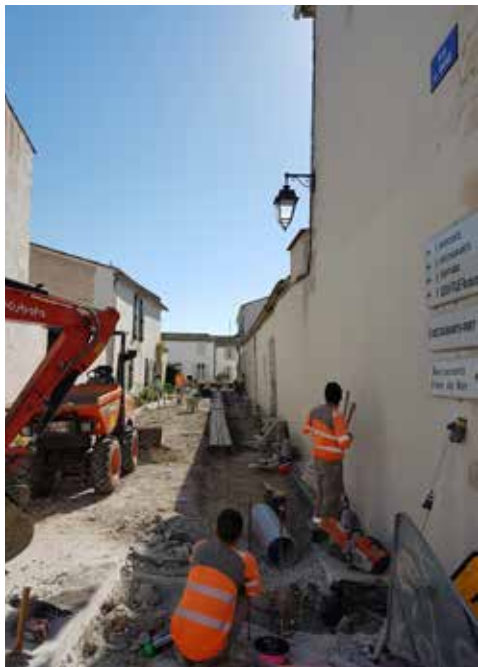
Les travaux d'aménagement de la rue du Rivage et du carrefour de la rue Charles Biret sont en cours de réalisation
