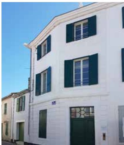
17 mois ont été nécessaires pour la réhabilitation de l'ancien couvent du bâtiment
