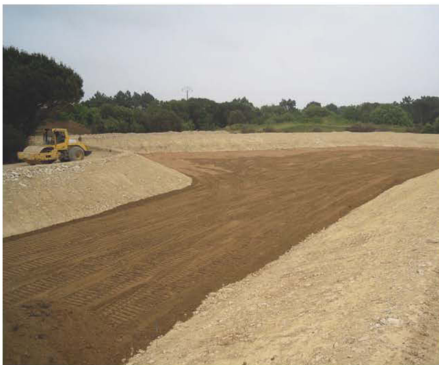
Le chantier du bassin de la réserve de substitution
