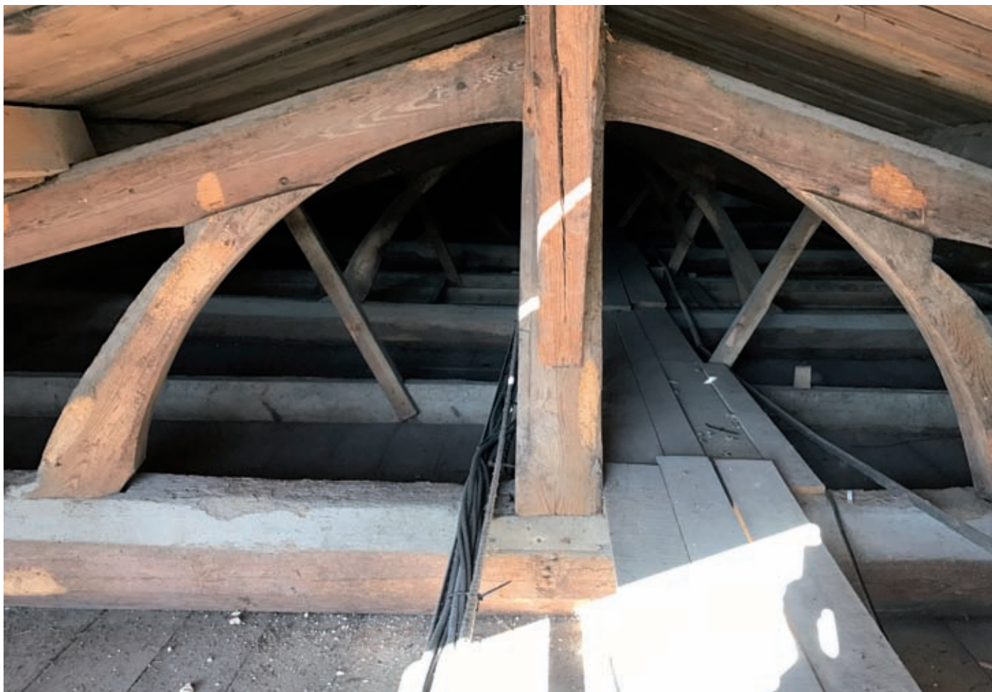
Charpente : coque de bateau renversée
