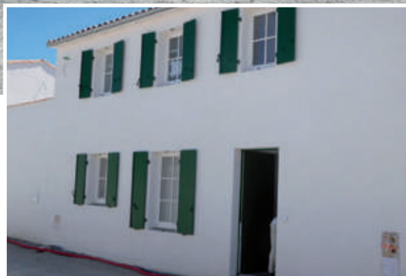
Maison côté rue
