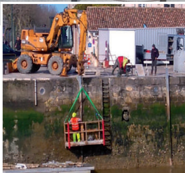
Travaux sur les attaches des pontons
